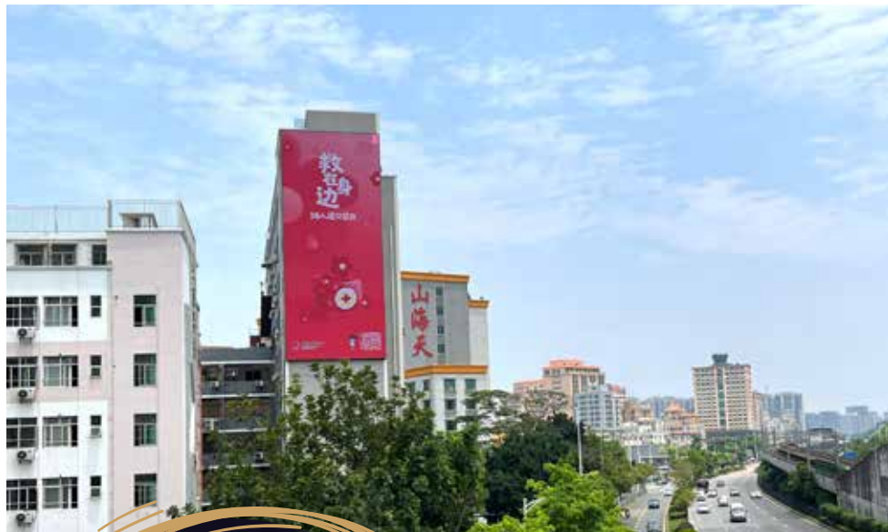
深圳宝安区港华兴大厦
