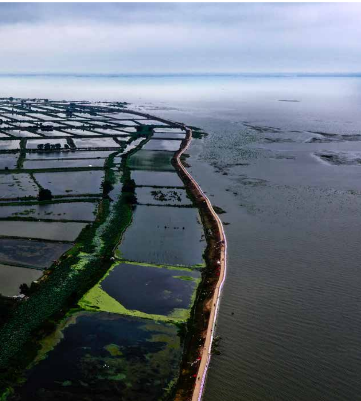
三八湖防汛大堤是 8800 亩精养鱼池和守护当地群众安全的最后一道防线
