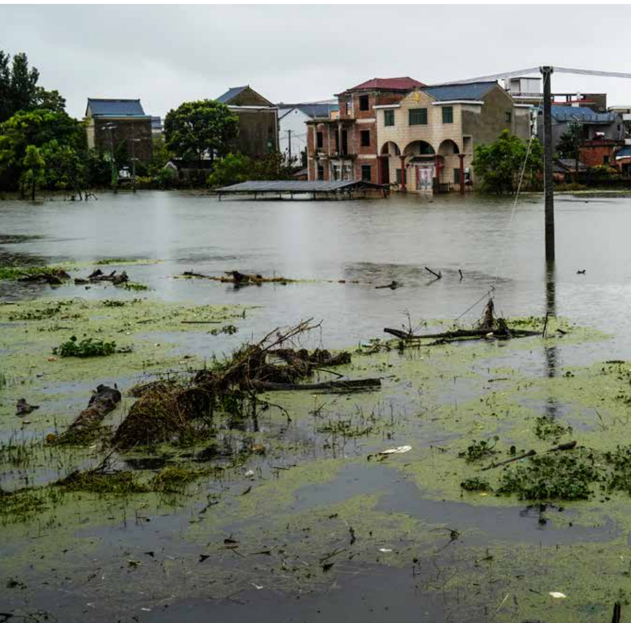
江西遭遇大范围强降雨袭击，多个县市区受洪涝灾害影响严重
