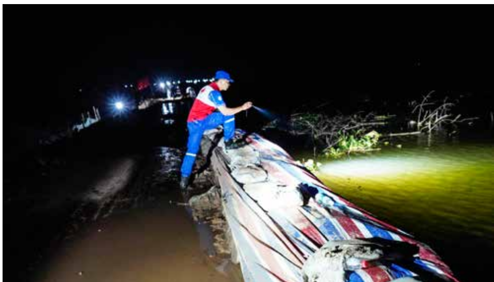
沿着三八湖堤，防汛人员边走边看，看着哪里情况不对，他们就下去用手探、用脚探， 不放过任何一个疑点
